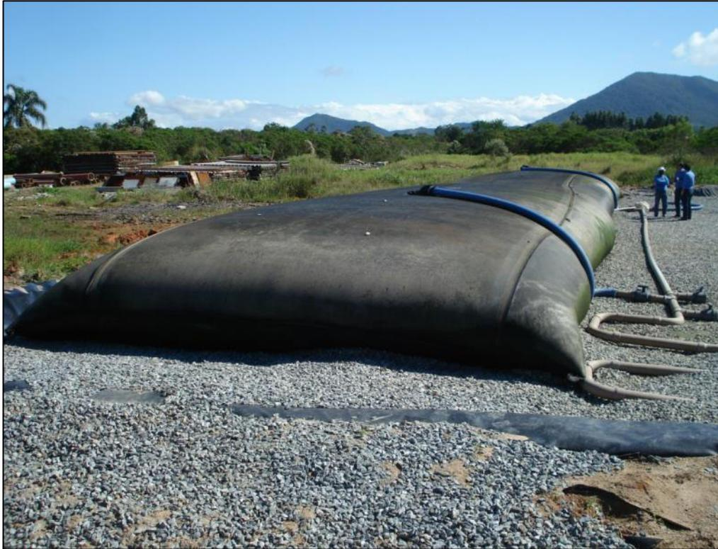
Il fango viene pompato all'interno dei tubi in geotessile.
